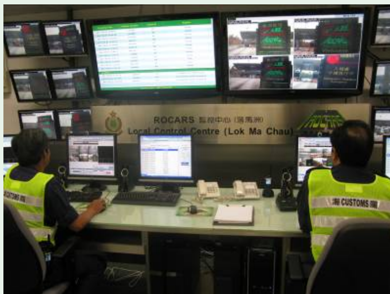
設於落馬洲管制站的道路貨物資料系統口岸監控中心。
