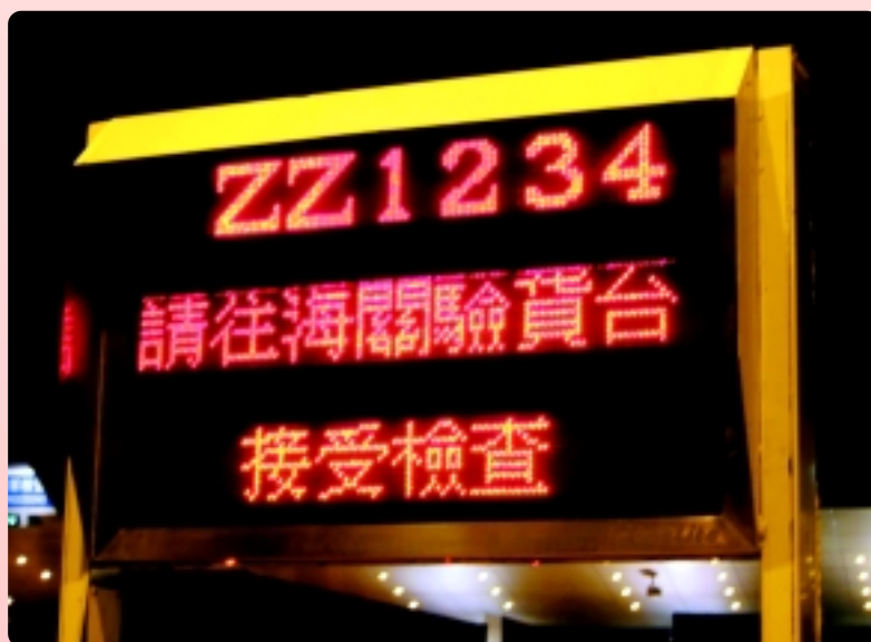
△ 安裝於落馬洲管制站的電子顯示板。
