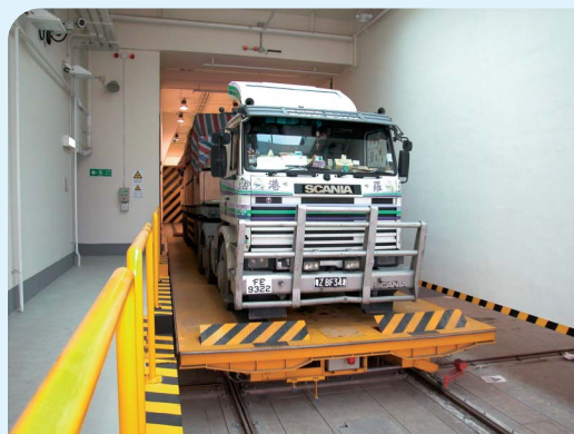
車輛X光檢查大樓內的X光隧道。
