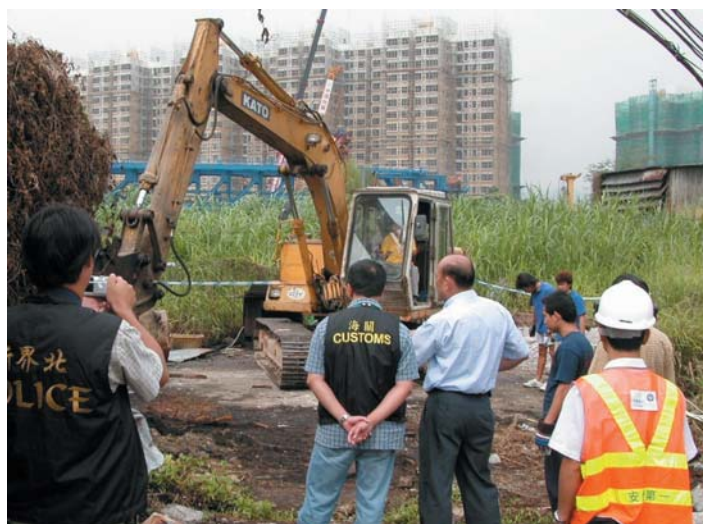
柴油管制組同事正在指揮工人以大型鏟泥車把化油工場設施移走。
