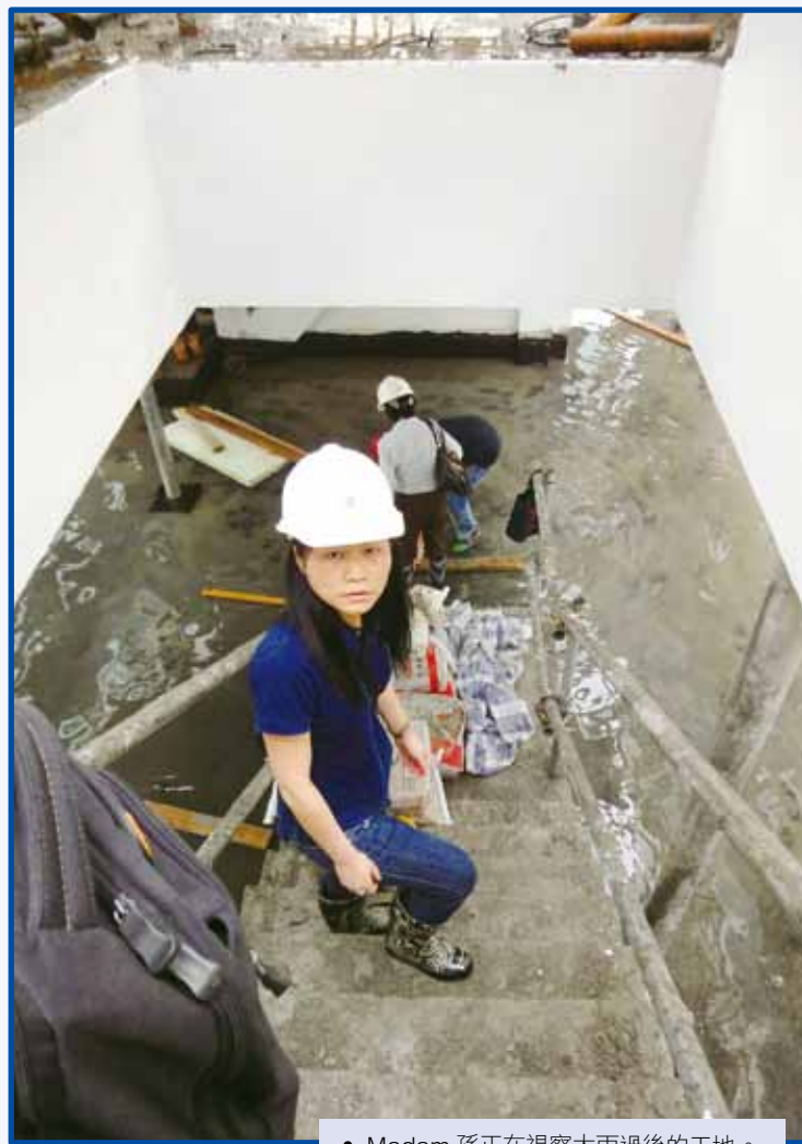
• Madam 孫正在視察大雨過後的工地。
