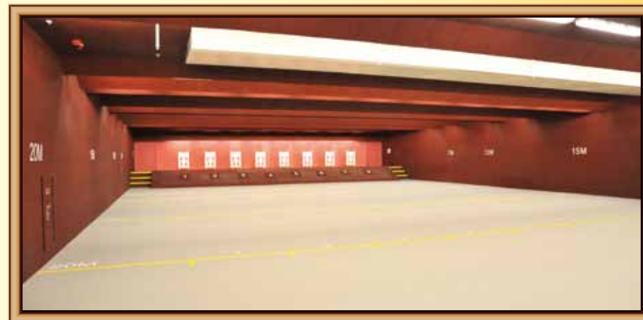
總部大樓 16 樓的綜合練靶場，室內的射擊場地安裝了滲透式空調系統，可帶走「燒槍」時的氣體；場內的天花、牆壁和地下都分別加裝了防子彈反彈的橡膠磚以確保安全。綜合練靶場另設有 2 個小型室內射擊場，室內電腦系統提供模擬情境個案，以訓練同事的應變能力
