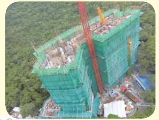
宿舍近期施工進度
