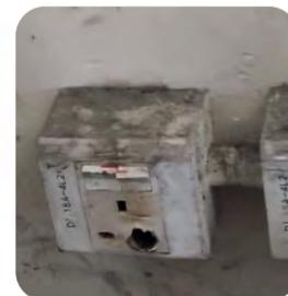
避免電力負荷過重，造成插座過熱，甚至損壞
